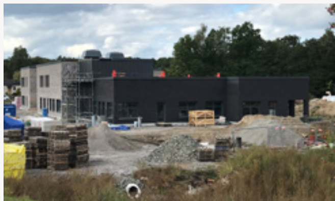
Vid Grönängsskolan byggs en ny modern förskola i två våningsplan för 105 barn bestående av 6 avdelningar som även kommer att inrymma nattsverksamhet. Foto: Jonny Persson.
