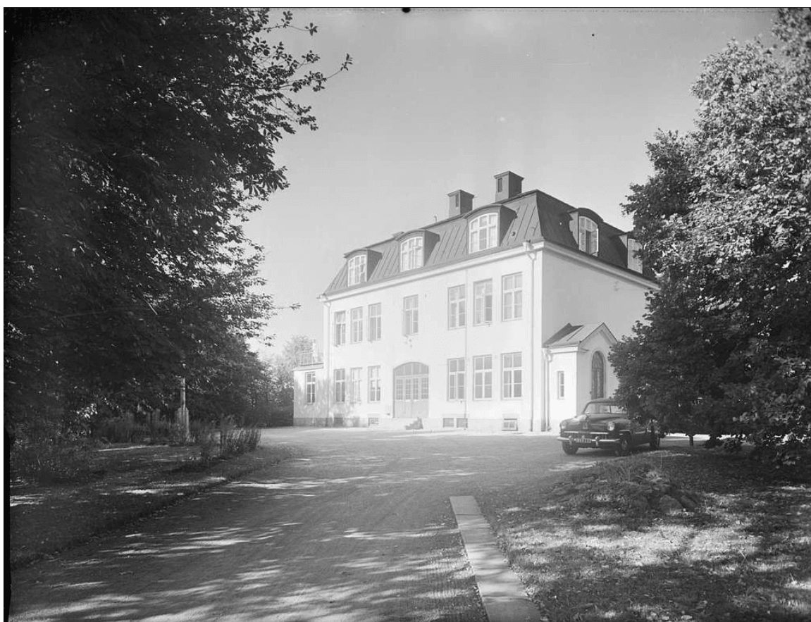
Figur 12: Sjukhusbyggnaden innan större ombyggnationer. Bild från kulturmiljöutredningen.
